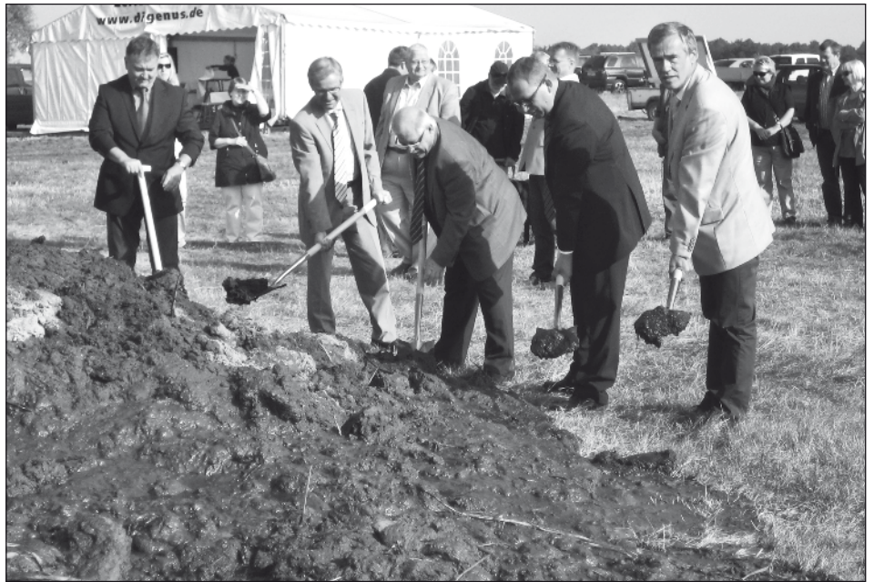
150.000 Tonnen Schlamm sollen aus der Alten Elbe gebaggert werden. Symbolisiert wurde das mit dem ersten Spatenstich. Foto: G. Lauenroth
