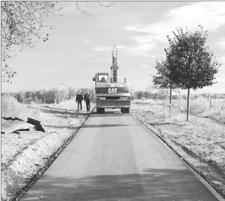
Im Oktober wurde der rund 2,5 Kilometer lange Radweg zwischen Lostau und Möser mit einer drei Meter breiten Asphaltdecke versehen. Am 26. Oktober wurde die Strecke, die im Rahmen des ländlichen Wegebbaus entstand und gefördert wurde, freigegeben. Die Strecke ist bis auf landwirtschaftliche Fahrzeuge für jeglichen motorisierten Verkehr gesperrt.
