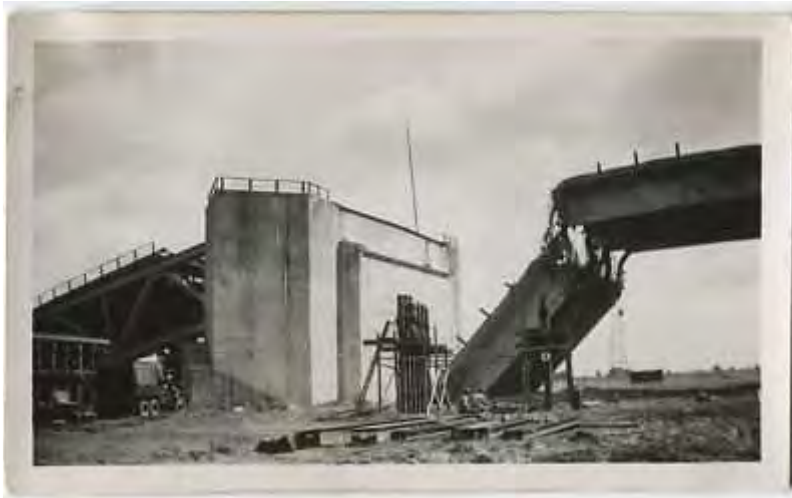
Abbildung 3 Hohenwarthe gesprengte Elbbrücke 1945 Quelle: US Army
